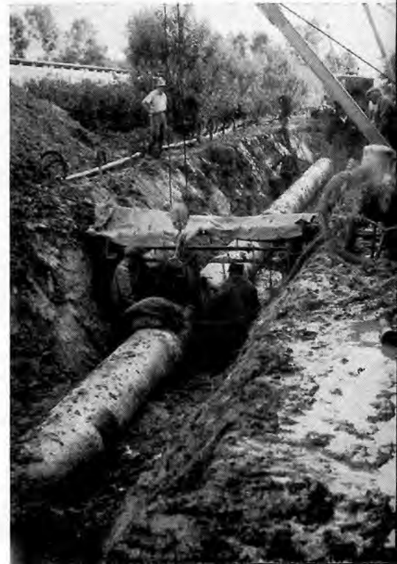
DAS VERSCHWEISSEN der Nahtstellen war eine wichtige Arbeit, von der die Dichtigkeit des Leitungssystems abhängt
