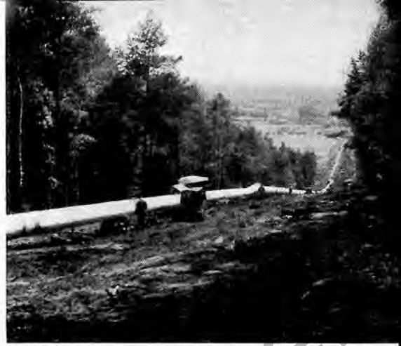
ÜBER EIN JAHR benötigten 10 Baukolonnen, um die 390 km lange „stählerne Schlange“ vom Meer zum Rhein zu verlegen
