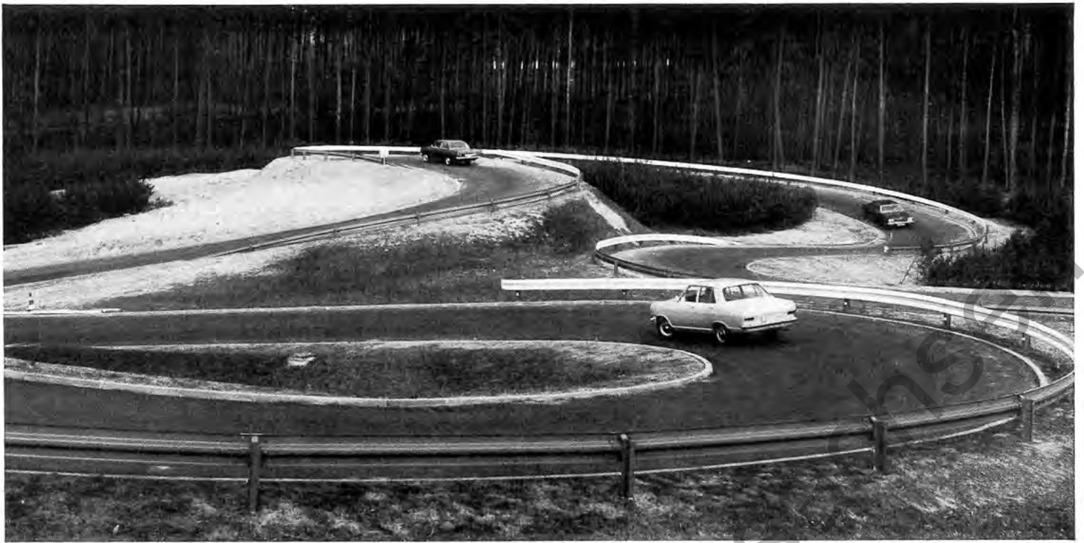
Die Zu- und Abfahrtsstraßen des Berggeländes auf dem Opel-Prüfgebiet in Dudenhofen sind wie Pflasterstraßen mit engen u. engsten Kehren angelegt.
