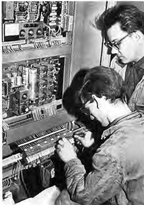
Der Transport durch die Schweißstraße ist nicht in Ordnung. C. Ostojic (links) und M. Grunow bei der Fehlersuche.
