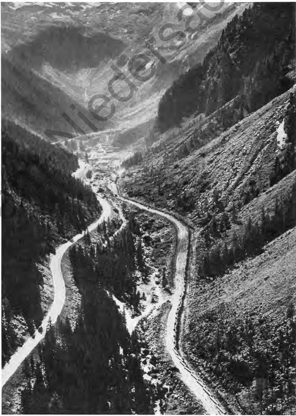
Baustelle in den Alpen am Nordhang des Felbertauerntunnels.
