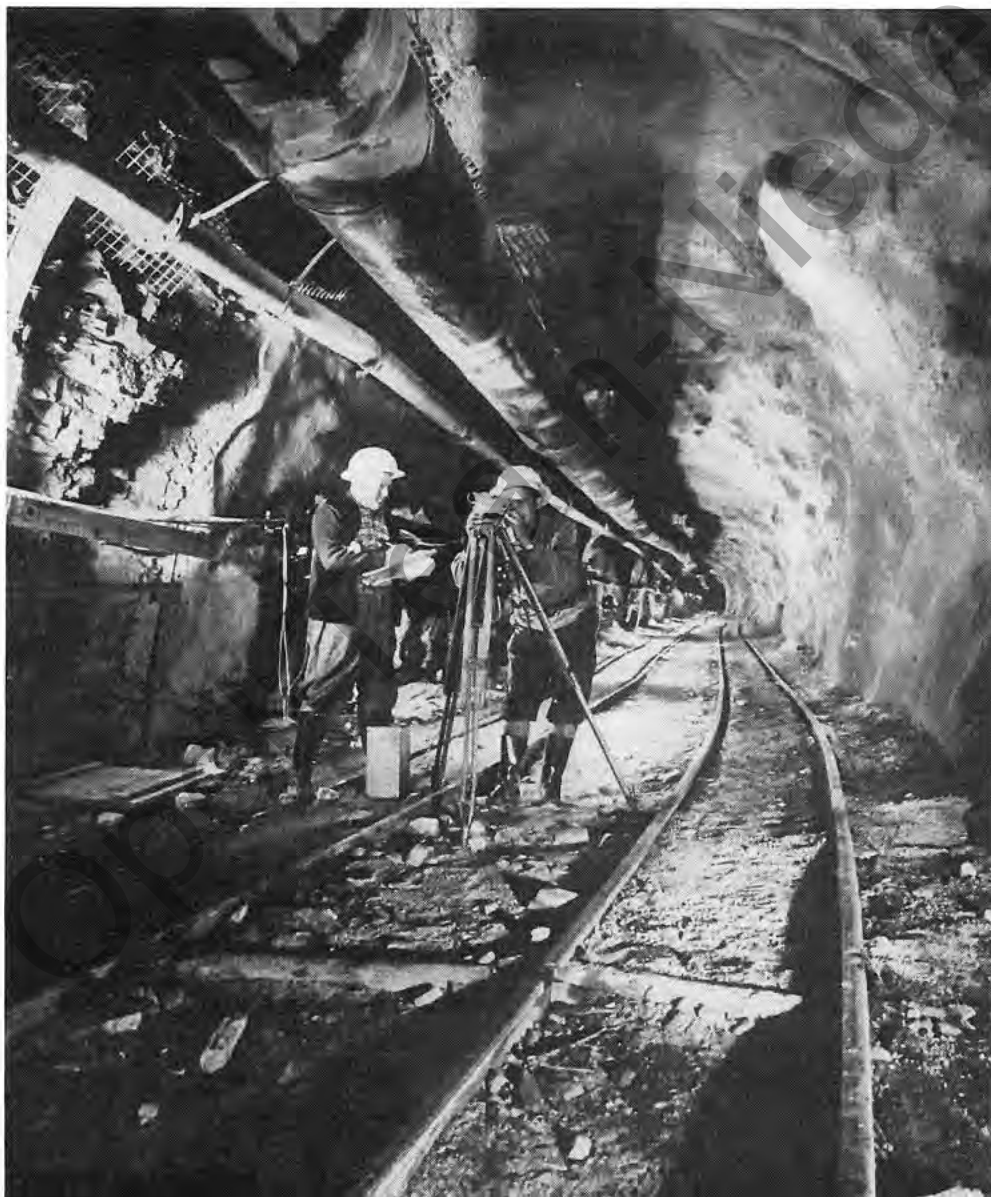
Vermessungsarbeiten im Felbertauerntunnel
