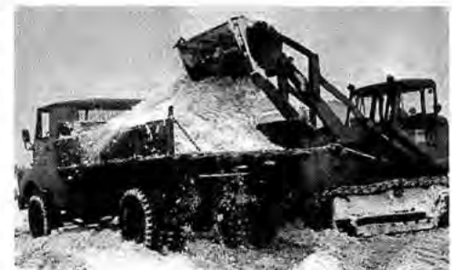
30 000 cbm Schnee wurden abgefahren. Unser Bild zeigt, wie gerade ein Lkw von einem Räumgerät beladen wird.
