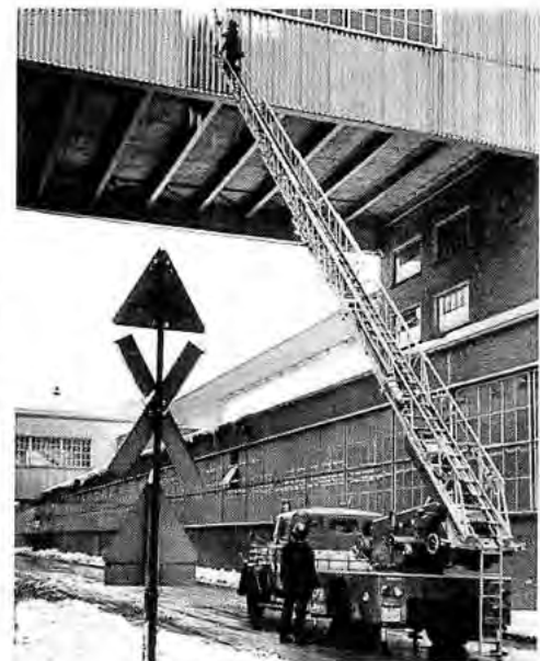
Unfallgefahr durch herabfallende Eiszapfen. Die Feuerwehr mußte eingreifen und die Eiszapfen beseitigen.
