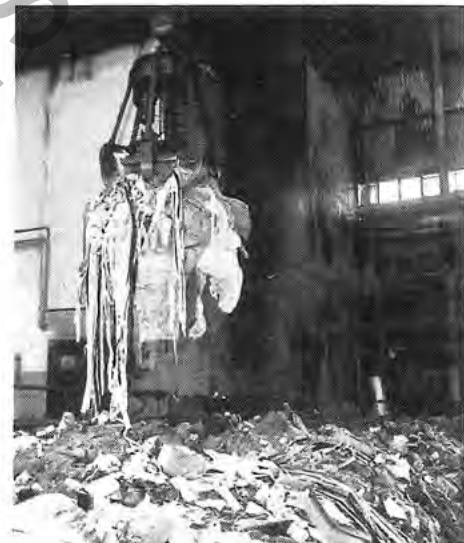
Recycling im weiteren Sinne: Brennbarer Müll wird nicht auf Mülldeponien gelagert, sondern kommt in die Müllverbrennungsanlage, wo er zur Energiegewinnung beiträgt.
