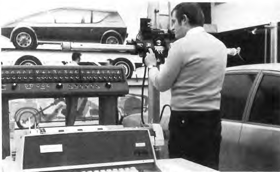
Hier wird die Außenhaut des Plastilin-Modells mit dem Digital Point Taker abgetastet.
