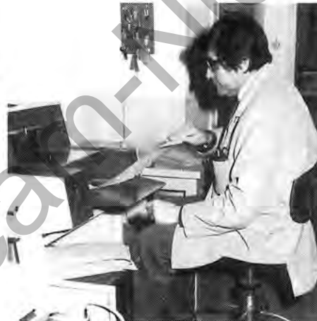
Mitarbeiter S. Gierlich am Mikrofilm-Entwicklungsgerät. Er legt gerade eine belichtete Filmkassette ein. Das Entwickeln dauert etwa 20 Minuten.
