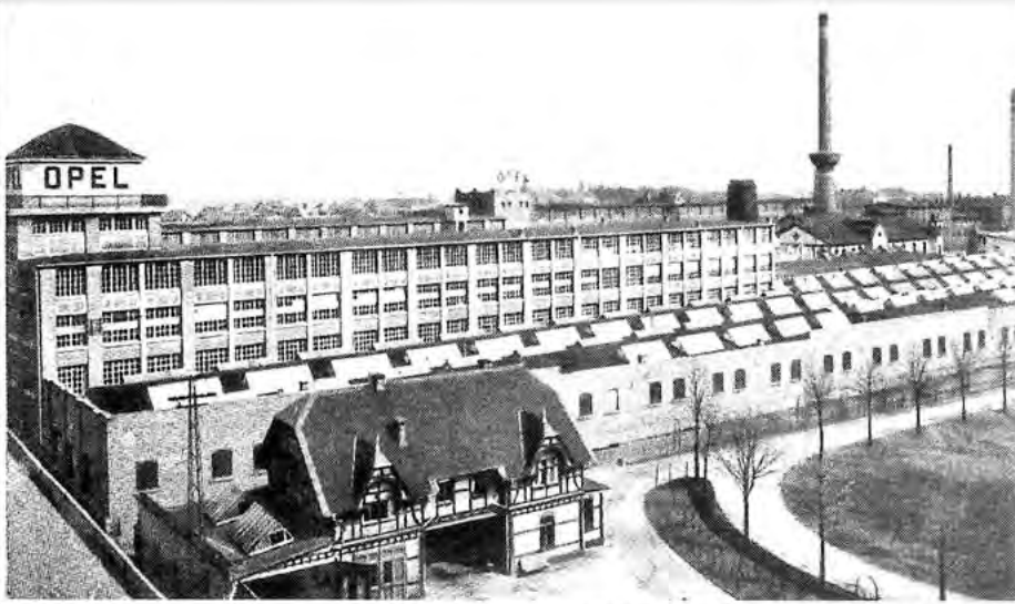
Teilansicht von Südwesten. Vorn das Garagenhaus und ein Stück der ovalen Einfahrbahn. Im Gebäude dahinter befindet sich die Automobil-Endmontage.
