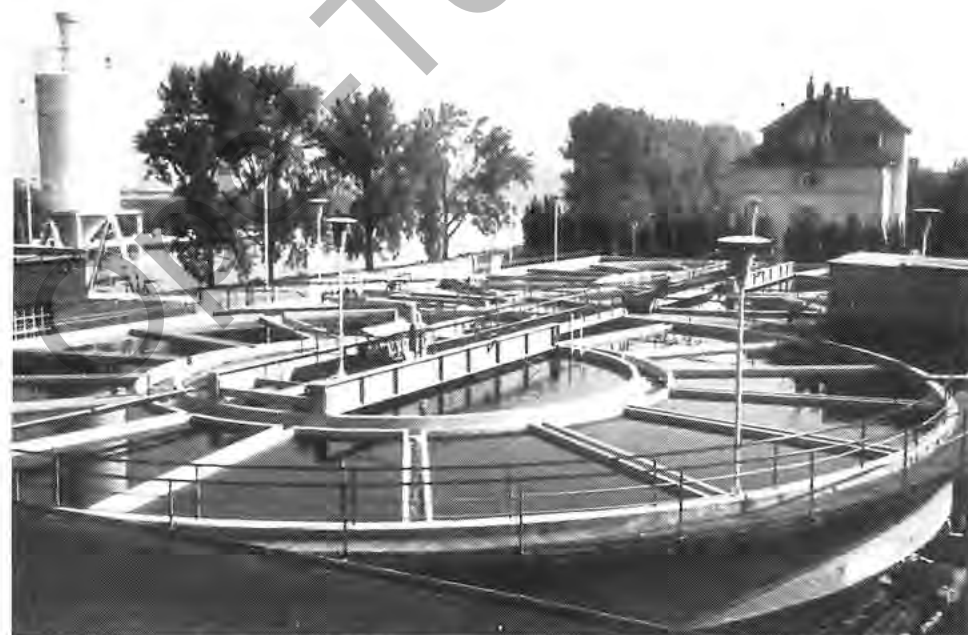
Die Mainwasser-Aufbereitungsanlage des Rüsselsheimer Werkes.
