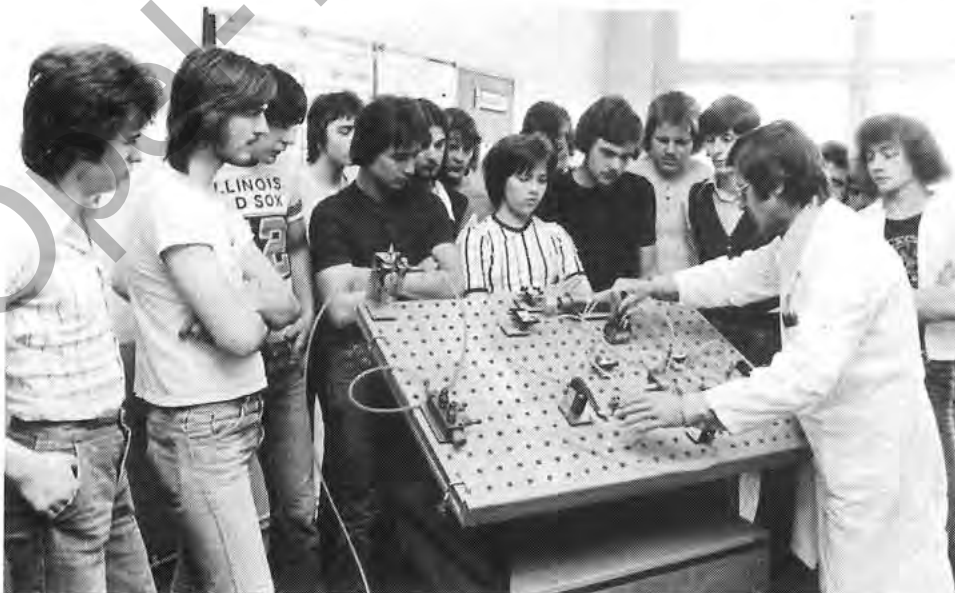
Linkes Bild: Durch umfangreiche Schaltungsübungen am Pneumatik-Trainer hat der Auszubildende die Möglichkeit, seine im theoretischen Unterricht erworbenen Kenntnisse praktisch anzuwenden. Eine Fehlersuche am Modell wird hier einer Betriebsschlossergruppe gezeigt. Ein Schnappschuß aus der Werkberufsschule.
