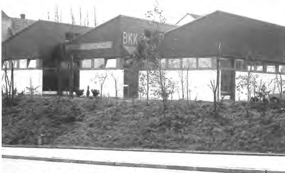
Außenansicht der neuen BKK unseres Bochumer Werkes.
