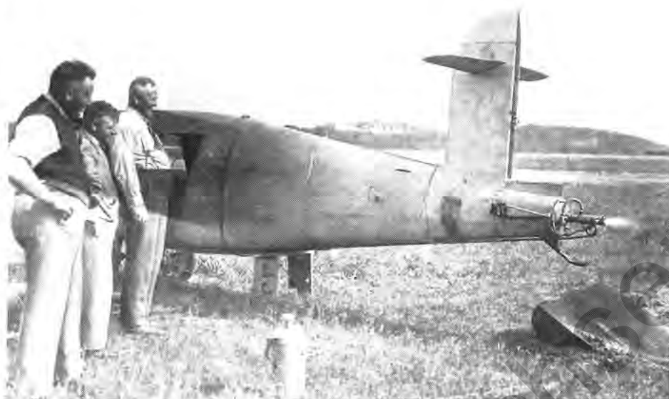
Ein Segelflugzeugmodell wird für Raketenversuche vorbereitet. Am 30. September 1929 gelang als dritter Versuch der Start. Das Flugzeug hob sauber ab, und Fritz von Opel konnte in 30 m Höhe noch 5 Raketen zünden, ehe er niedergehen mußte.
