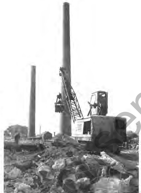
Abbrucharbeiten der Kokerei 1960.
