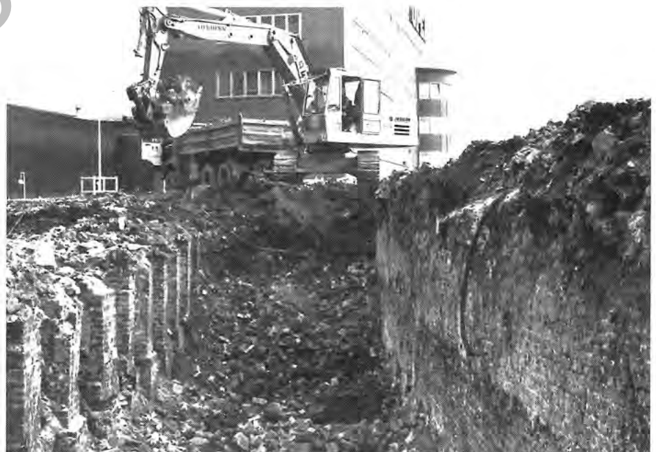
Der Bagger frißt sich in den historischen Grund. Im Hintergrund der Bau D 1.
