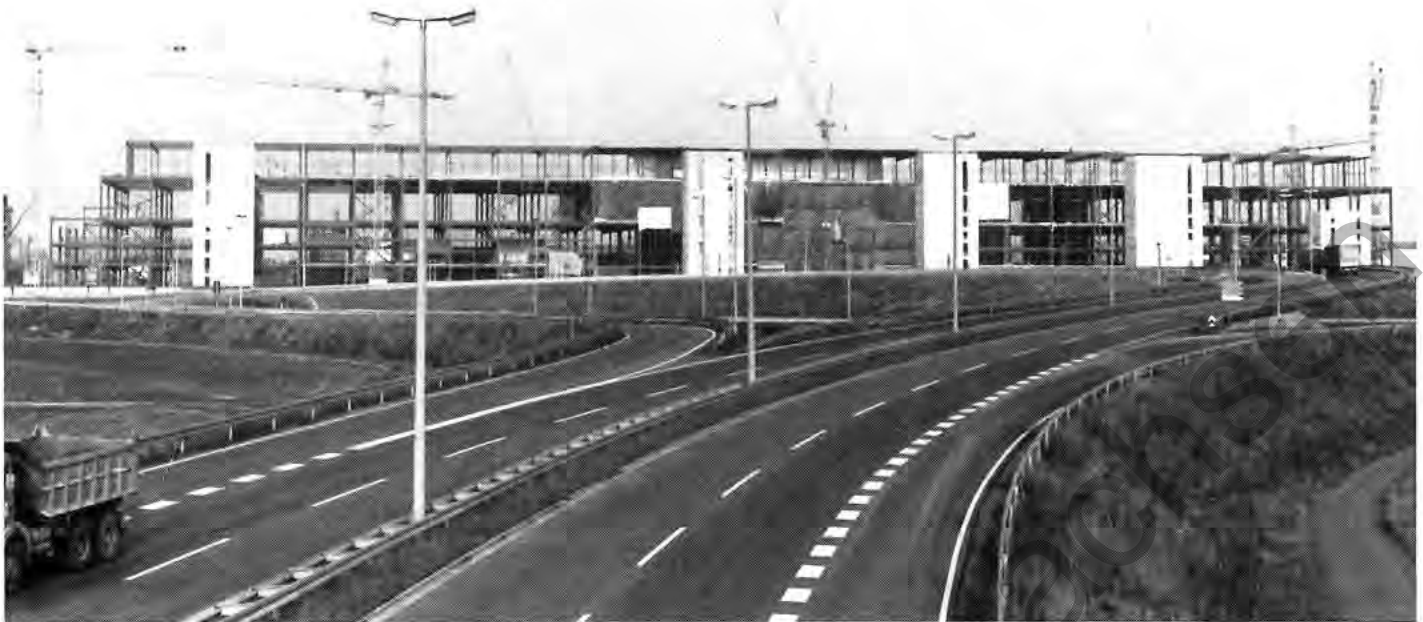
Langsam nimmt die neue Spritzlackiererei im Südwesten des Rüsselsheimer Werksgeländes Gestalt an. Auf dem Bildausschnitt lassen sich die Ausmaße dieses Produktionskomplexes nur erahnen.
