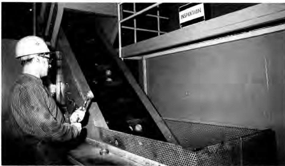
Am Ende des Arbeitsprozesses erkennt man Mitarbeiter Rudolf Grimmer bei der Maß- und Formkontrolle der Schmiederohlinge, die gerade die Anlage verlassen.
