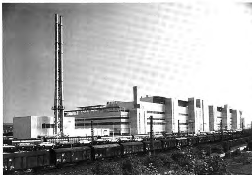
Die neue Lackiererei im Werk Rüsselsheim. Links das für diesen Komplex neu errichtete Kesselhaus K 124.
