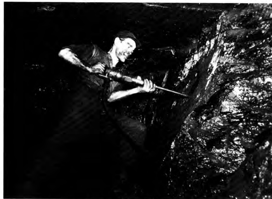
Abbau der Kohle in 1.000 m Tiefe in der ehemaligen Bochumer Zeche Dannenbaum, die seinerzeit dem großen Zechensterben zum Opfer fiel. Auf dem Bergwerksgelände entstand bald darauf das Opel-Werk I.
