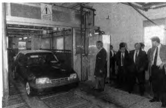
Dichtung: Die Berieselungskammer durchfahren alle Kadett
