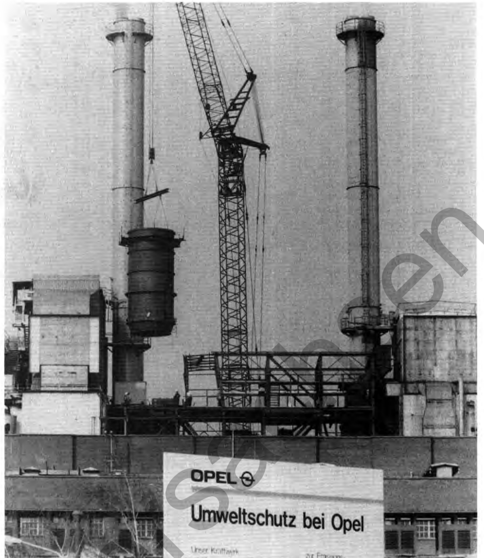
Nachrüstung mit Kran
