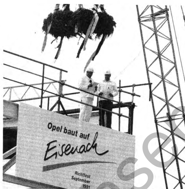
Tradition: Polier Hans Zinke spricht den Richtspruch
