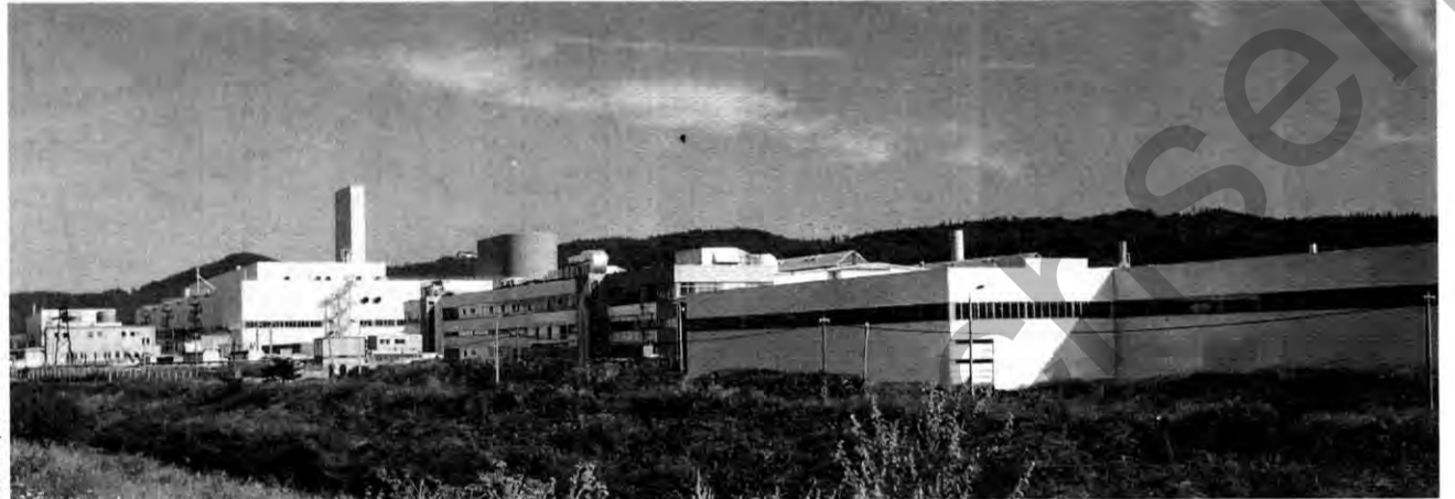
Raumplanung: 300 000 Quadratmeter für das neue Werk
