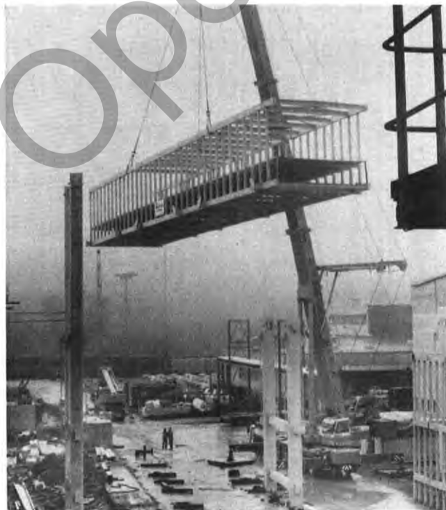
Maßarbeit: Die letzte Brücke schwebt ein
