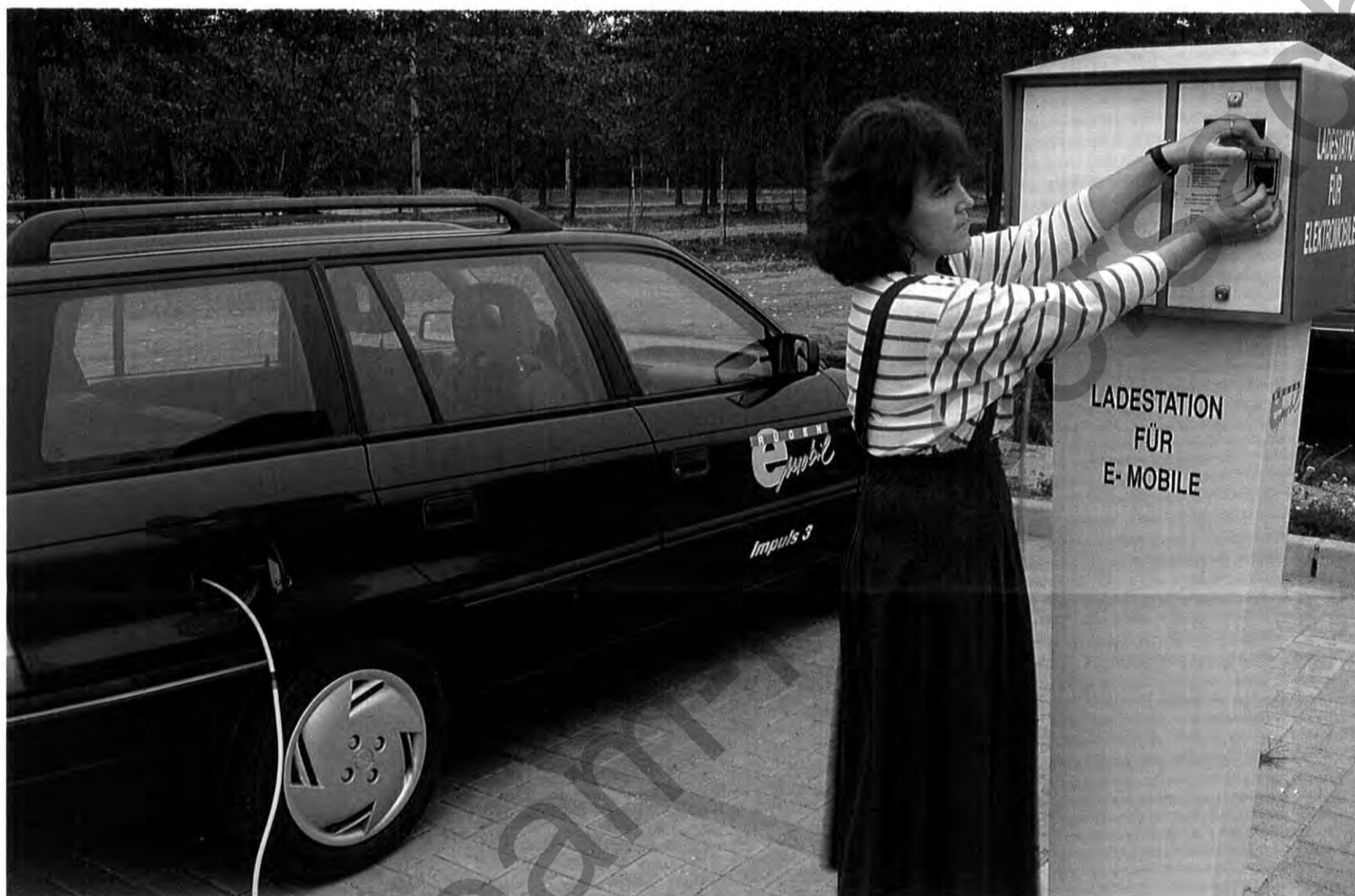
Sprit aus der Steckdose: In Rügen bewähren sich zehn Astra Caravan mit Elektroantrieb
