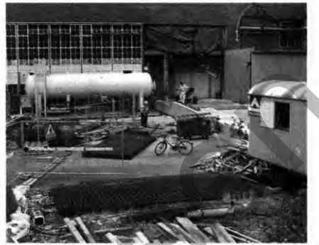
Endphase: Durchbruch im K40
