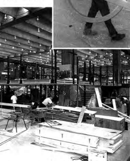
Großbaustelle: Am Opel-Stand wurde bis zuletzt rund um die Uhr gearbeitet
