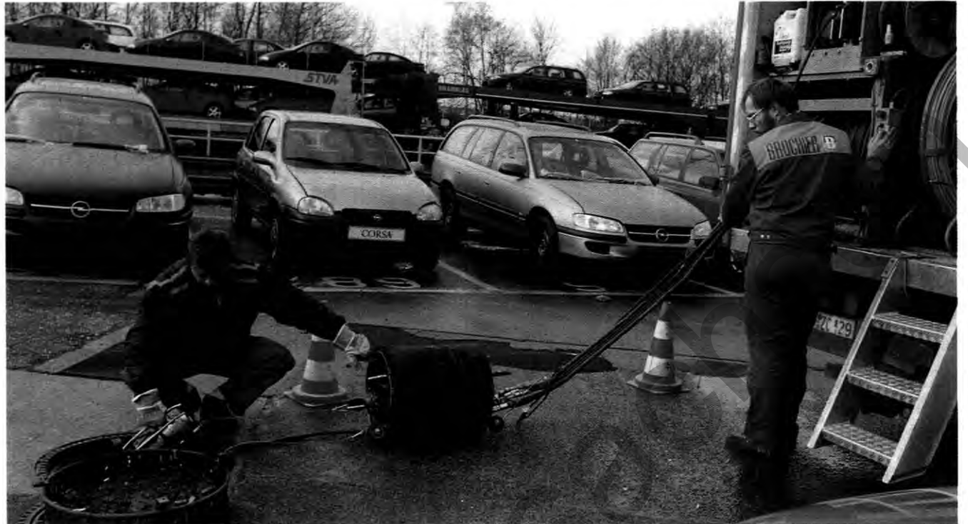
Packend: Bei Opel verschwindet nicht der Tiger im Tank, sondern der Packer im Kanal. Kameraunterstützt dichtet er Muffen ab
