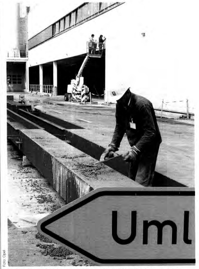
E-Klasse: Der Anbau wird die Rostschutzstufe 3 beherbergen
