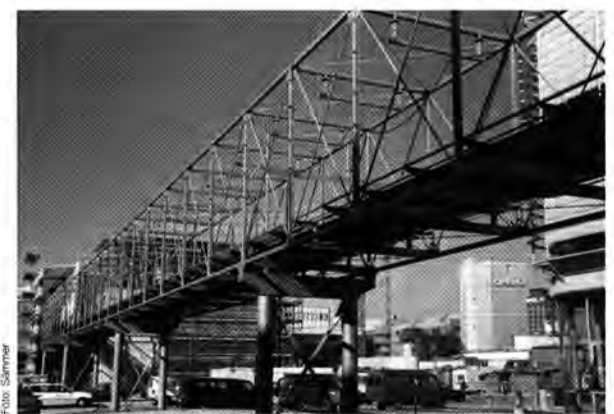
Opel hat schon viele Brücken in andere Kontinente und Kulturen geschlagen – jetzt war auch mal eine im Werk fällig. Doch auch die ist gewaltig: 125 Meter lang ist die Fußgängerbrücke, die künftig die neue Unternehmenszentrale und das derzeit entstehende Besucherzentrum Opel live verbindet. Die Konstruktion der Aluminium-Brücke dauerte drei Wochen. Sie besteht aus fünf Segmenten, die jeweils zehn Tonnen schwer sind, und ruht auf sechs Stützen. Die Fenster können elektronisch geöffnet und geschlossen werden.
