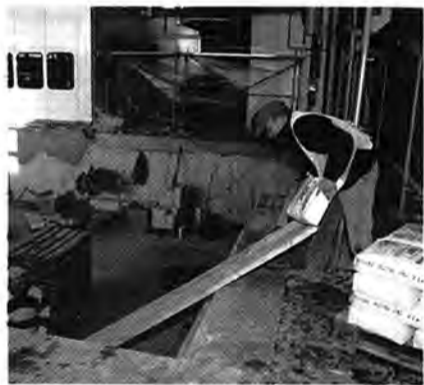
U-Bahn: Der Umbau fängt im Keller an
