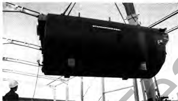
Kessellift: Die 56-Tonnen-Kessel brauchen einen kräftigen Kran
