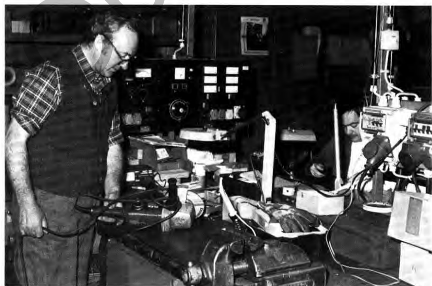
Die Mitarbeiter J. Urschel und Ph. Christmann bei der Reparatur von elektrischen Handwerkszeugen.
