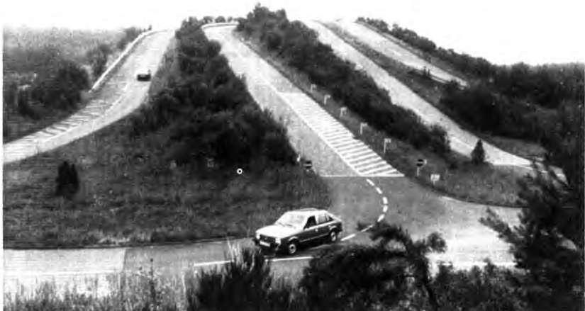
Der „Berg der Leiden“: auf diesem künstlich aufgeschütteten Hügel müssen Steigungen bis zu 30 Prozent überwunden werden.
