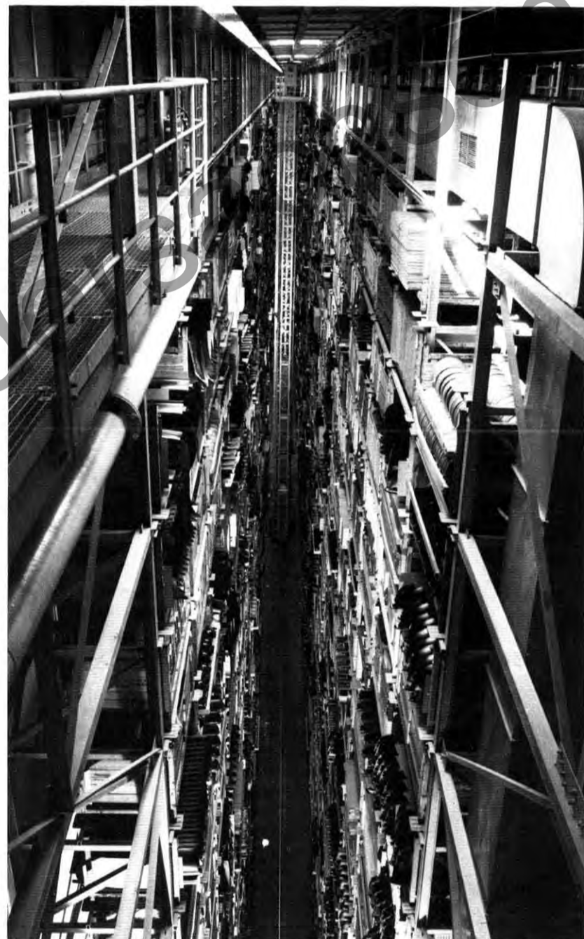
Blick in eine Regalgasse: in der Mitte einer der riesigen Krane, ein Regalförderfahrzeug („RFZ“), von denen jedes für eine der zehn Gassen zuständig ist. Es nimmt die Paletten auf und bringt sie an das vom Prozeßrechner angewiesene Fach, wo die Teile bis zum Abruf eingelagert werden.
