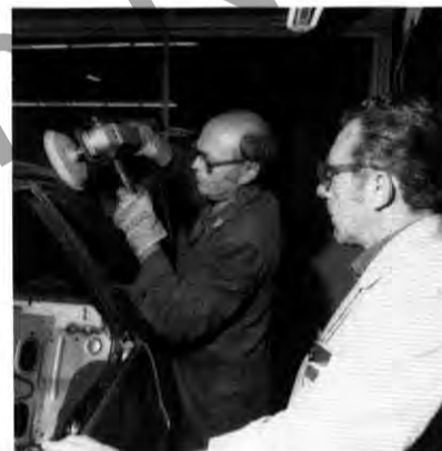
Mitarbeiter Dieter Krummeck bei einer Schleifoperation an einer Dachkuppe; rechts neben ihm Meister Heinrich Stephan, Produktion-Karosserie-Rohmontage.
