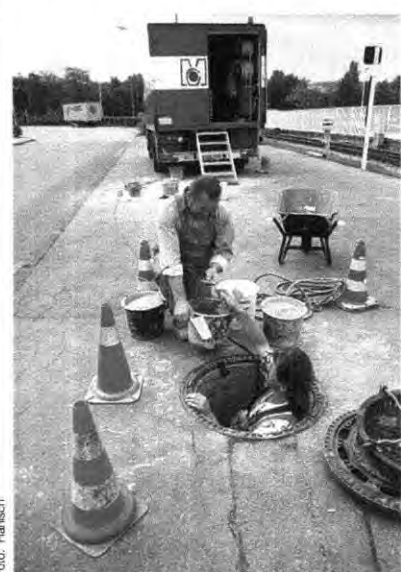
Auf Tauchstation: Kanalinspektion
