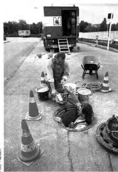
Auf Tauchstation: Kanalinspektion
