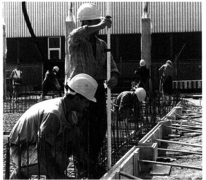
Offene Bürolandschaft: Die Bauarbeiten am K 150 gehen voran
