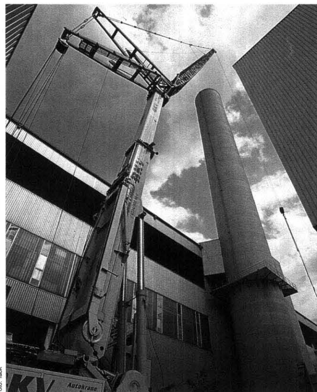
Abgehoben: Einige Umbauten benötigten Kran-Unterstützung
